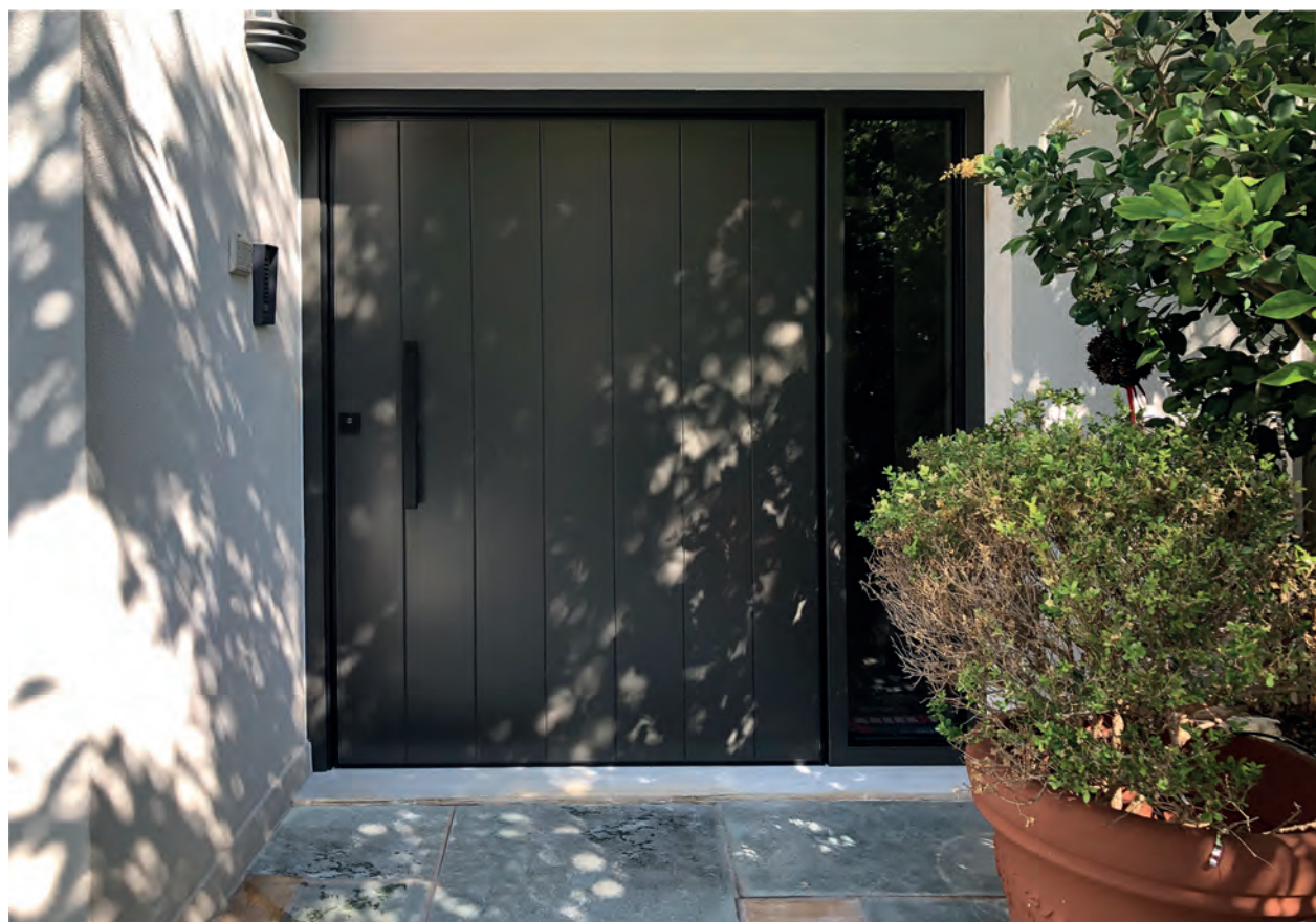
Αξονική πόρτα ασφαλείας με επένδυση από κόντρα πηλακέ θαλάσσης σε παντογράφο και βαφή ήλακα Security pivot door dressed in marine plywood panel
