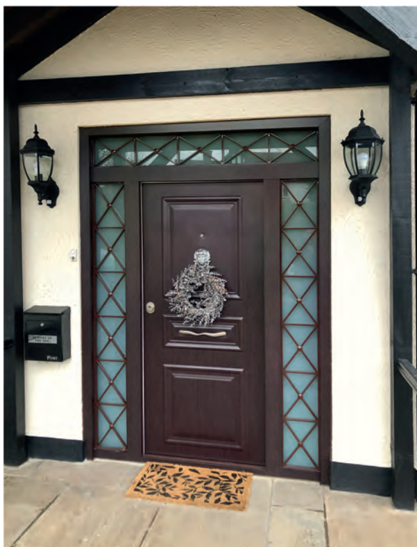
Πόρτα ασφαλείας με σταθερά και φεγγίτη τζαμωτά-χιαστή και επένδυση αλουμινίου σε χρώμα ξύλου Single leaf security door with glazed side panels and skylight with iron bars. Outside panels in aluminium imitation wood color
