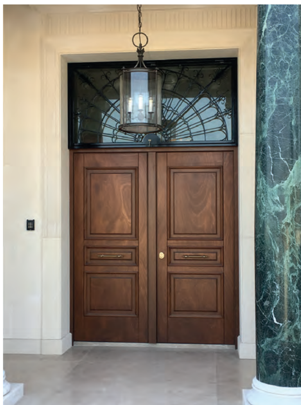
Δίφυλλη πόρτα ασφαλείας με φεγγίτη και επενδύσεις από κόντρα πηλακέ οσμε model Luxus 3 Double leaf security door with custom made skylight
